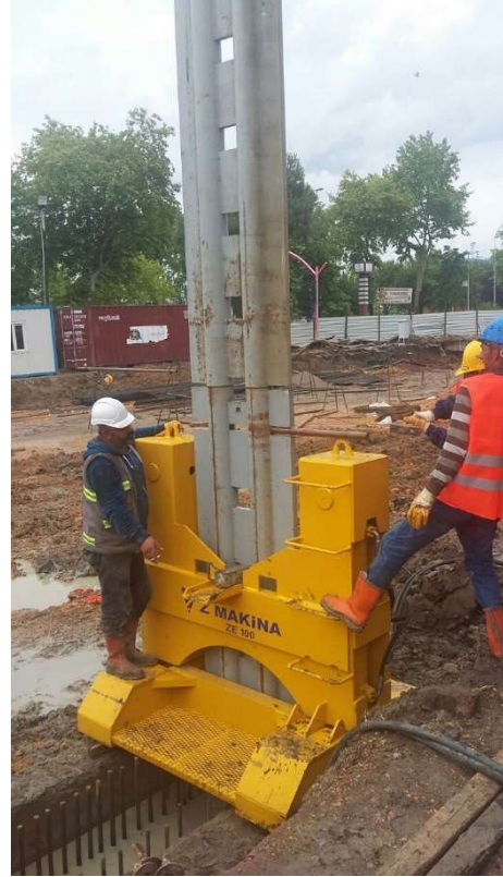
Resim 6_ Stop-end Boruları ve Ekstaraktör
