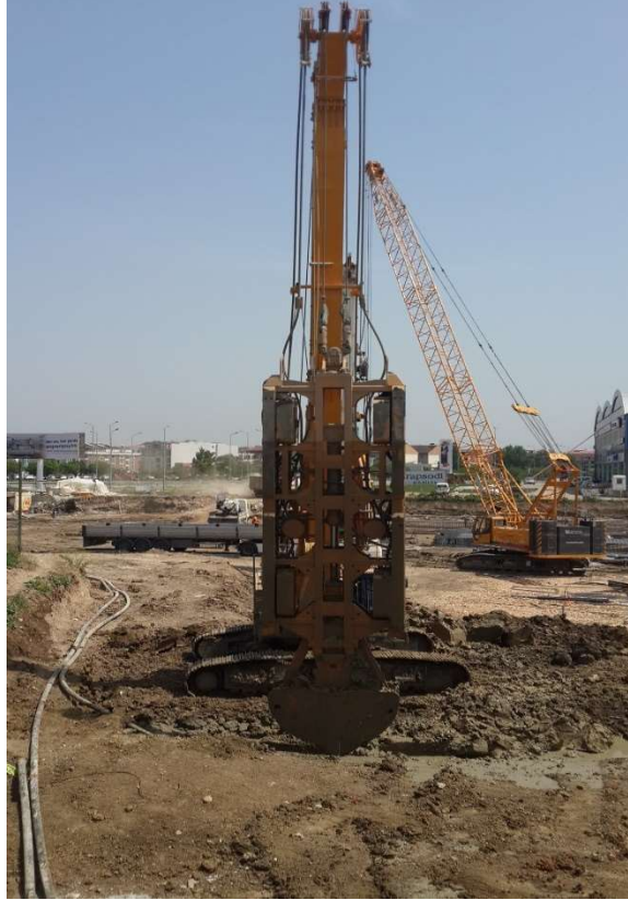
Resim 4_ Hidrolik Grab Diyafram Duvar Kazısı
