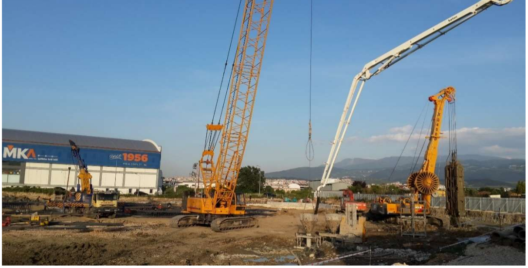
Resim 7 – Tremie Borusu Metodu ile Betonlama
