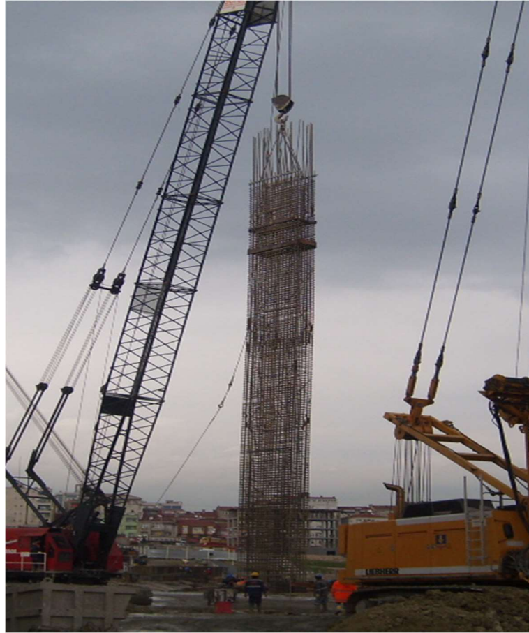
Resim 5_ Donatı Kafesinin Yerleştirilmesi
