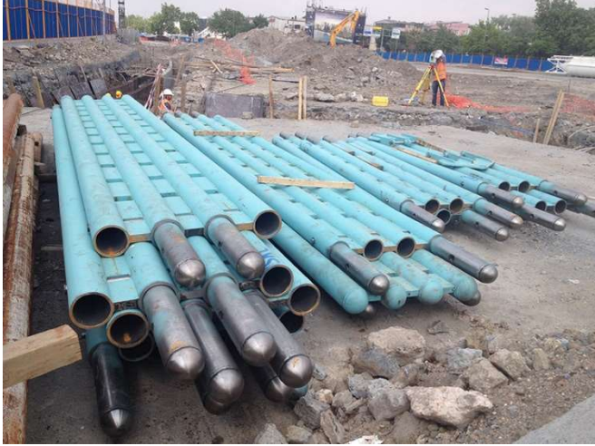
Resim 6_ Stop-end Boruları ve Ekstaraktör
